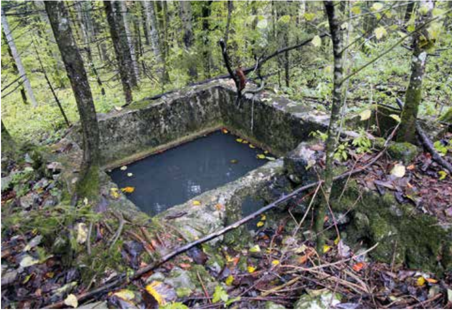
Temelji objekta in vodnega zbiralnika objekta mejne kontrole pred Otoškimi dolinami (© Valentin Schein)
